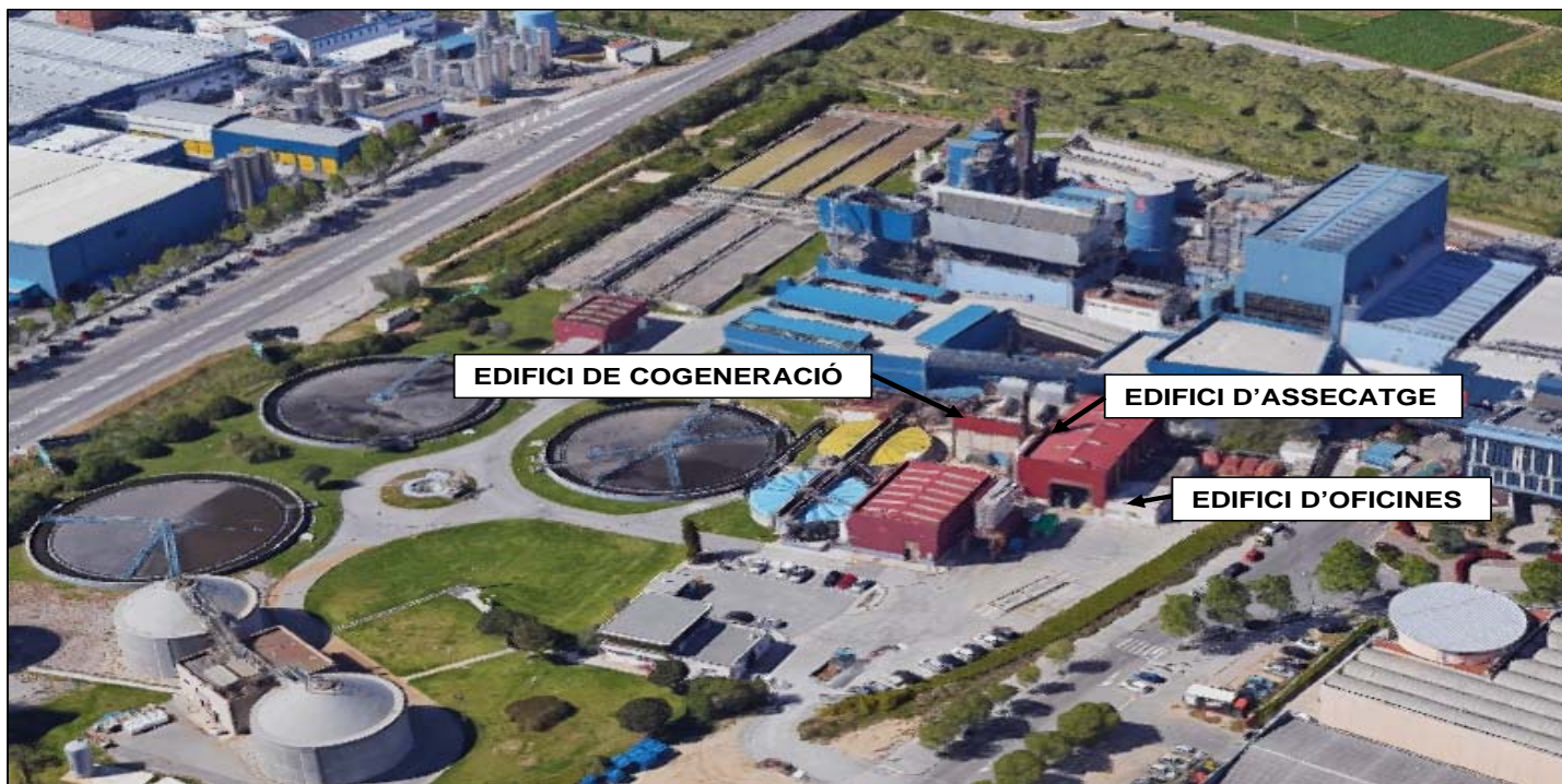
Imatge 2. Planta de tractament tèrmic eficient de Mataró. Vista general edificis
